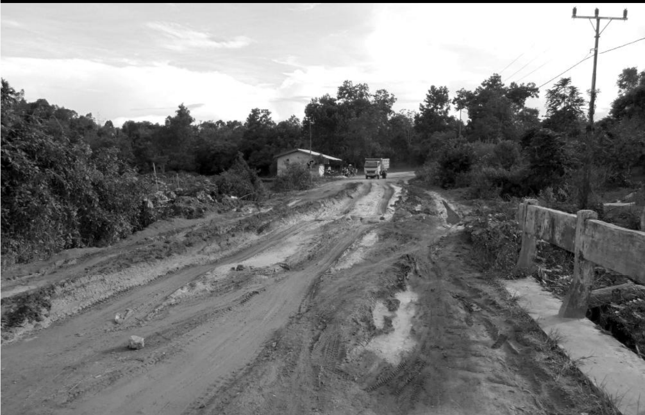
Foto 3 Kondisi jalan antar-kecamatan di Ketapang, Kalimantan Barat masih sangat buruk.
