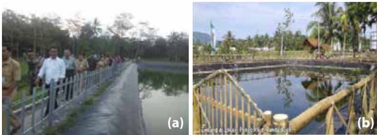
Gambar 24. Embung dengan pelapis geomembran di (a) Desa Giriroto, Kec. Ngemplak, Kab. Boyolali dan (b) Lokasi PENAS XV, Banda Aceh
