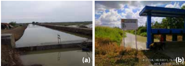
Gambar 27. Long storage di Kec. Sindang, Kab. Indramayu (a), Pintu air pada long storage di Merauke (b)
