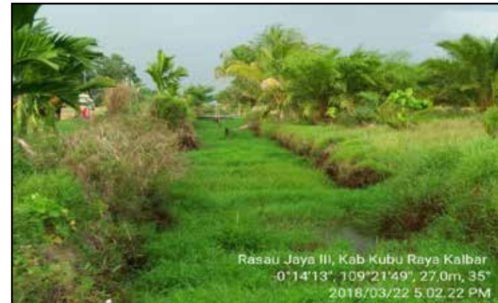
Gambar 19. Saluran yang tersumbat rumput
