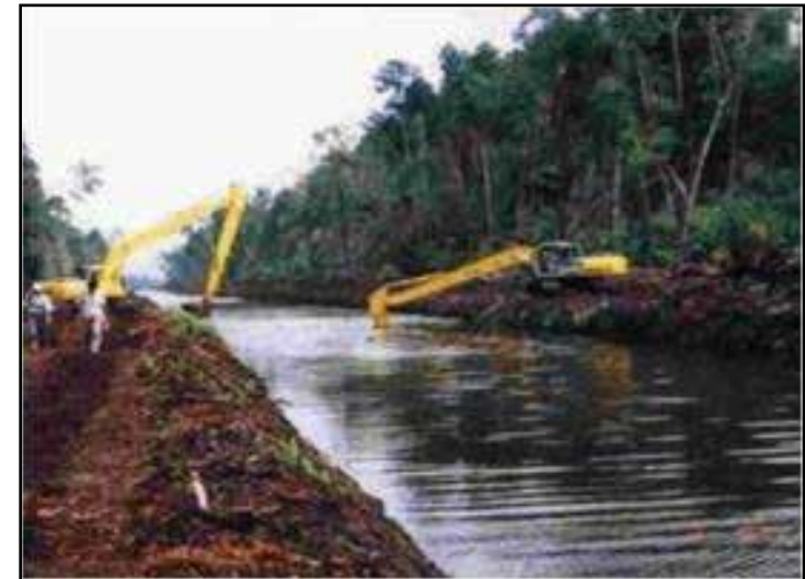
Gambar 17. Pembangunan jaringan tata air makro lahan rawa berupa saluran primer dan sekunder
