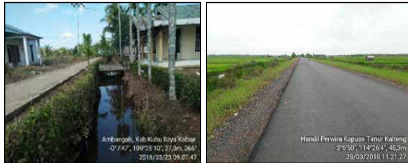
Gambar 20. Akses jalan di Kabupaten Kubu Raya, Kalbar (kiri) dan pengerasan jalan usaha tani dengan beton (kanan) di lahan rawa Kabupaten Kapuas, Kalteng
