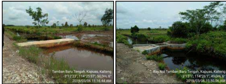
Gambar 21. Bangunan dam parit dan long storage di Desa Tamban Baru Tengah, Kab Kapuas, Kalimantan Tengah
