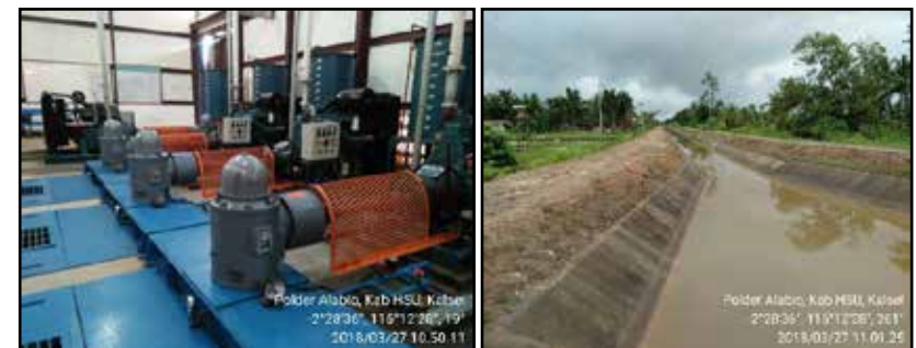
Gambar 22. Pompa air dan saluran primer irigasi pada sistem polder Alabio, Kabupaten Hulu Sungai Utara, Kalimantan Selatan
