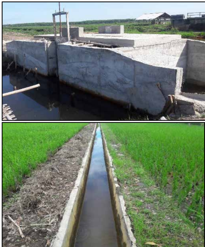
Gambar 31. Pembangunan pintu air (kiri) dan saluran kuarter pirosement (kanan).
